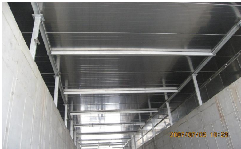
شکل ۴- نمای داخلی سقف و دیواره های از یک نوع تونل پاستوریزاسیون بستر رویش قارچ دکمه ای در حال احداث
