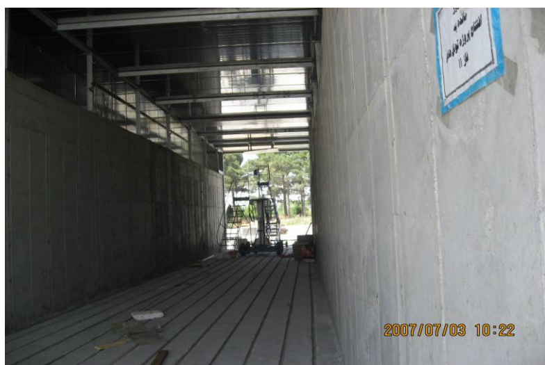
شکل ۵- نمای داخلی یک نوع تونل پاستوریزاسیون بستر رویش قارچ دکمه ای در حال احداث
