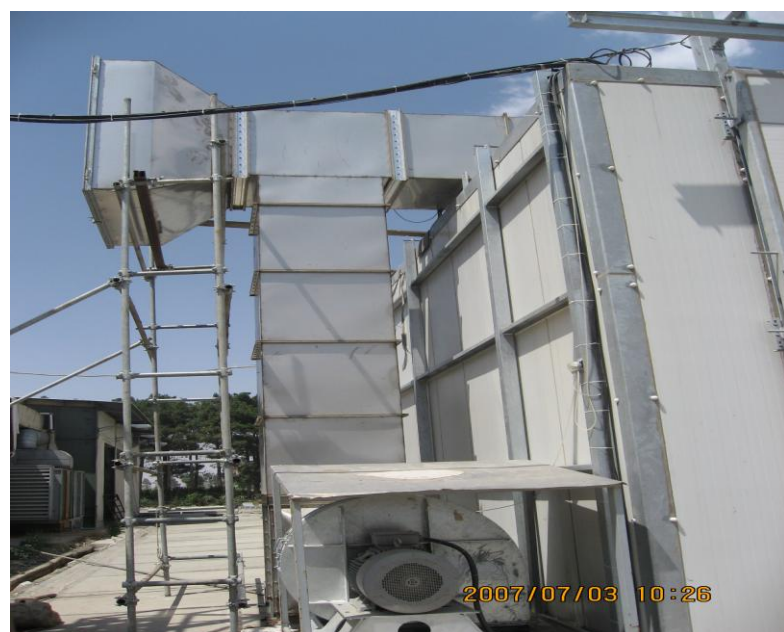
شکل ۶- نحوه استقرار هواساز تونل پاستوریزاسیون بستر رویش قارچ دکمه ای
